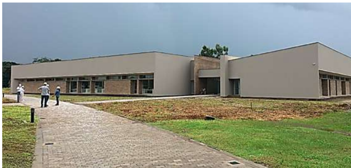
Figura 50. Fachada principal del módulo de laboratorios en el CEPC
